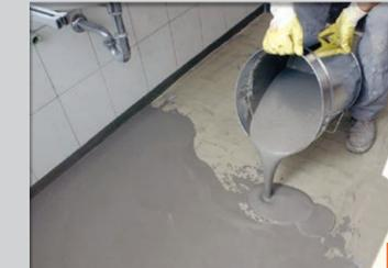
Bei größeren Flächen Boden mit PCI Periplan (von 2 bis 30 mm Schichtdicke) ausgleichen. Kommt ein anderer Oberbelag als Fliesen zum Einsatz ist grundsätzlich eine Mindestüberdeckung von 5 mm mit dem Boden-Ausgleich PCI Periplan erforderlich.
