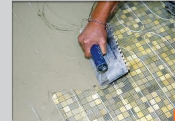
Anschließend die Heizmatte mit dem variablen Flexmörtel PCI Nanolight am Boden fixieren und bei kleineren Flächen vollflächig überspachteln. **Probelauf durchführen!**
