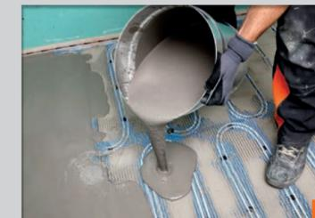
Gewebegittermatte mit dem Boden-Ausgleich PCI Periplan (von 2 – 30 mm Schichtdicke) bündig zu den Rohren egalieren.
