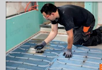
Gewebegittermatte am Boden mit dem variablen Flexmörtel PCI Nanolight punktuell fixieren oder Aquaheat-Niederhaltedübel in ein 6 mm Bohrloch eindrücken. **Probelauf durchführen!**
