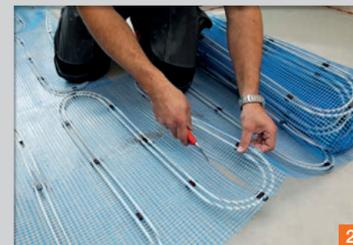
PCI Pecitape Silent rundum an allen aufgehenden Teilen 1 cm breit verlegen. Heizmattengitter auf dem Boden ausrollen, am Wendepunkt Heizmattengitter mit einer Schere auftrennen und in einer neuen Bahn zurück auslegen (Mäanderverlegung).
