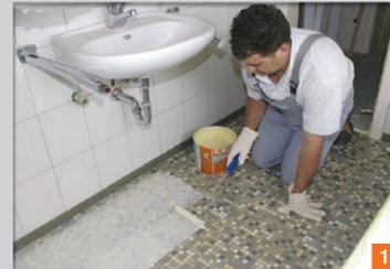
Alten Keramikbelag mit geeignetem Reiniger von haftungsmindernden Rückständen säubern. PCI Gisogrund 303 mit Flächenstreicher oder Quast auf dem Untergrund verteilen. Grundierung trocknen lassen.
