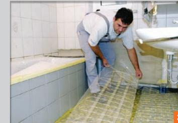
Am Wendepunkt Heizmattengitter mit einer Schere auftrennen und in einer neuen Bahn zurück auslegen (Mäanderverlegung, **beim Schneiden auf die Kabel achten!**) Zum Fixieren der Bahnen Schutzfolie am Klebeband entfernen und die Matte aufkleben.
