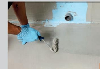
Im Spritzwasser beanspruchten Bereich, bei Duschen und Bädern mit haushaltsüblicher Nutzung, ist zusätzlich eine Abdichtung mit PCI Lastogum unter dem Keramikbelag aufzubringen.
