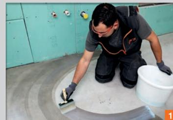
Estrich mit der lösemittelfreien Haft- und Schutzgrundierung PCI Gisogrund bzw. der lösemittelfreien Blitzgrundierung PCI Gisogrund Rapid grundieren.
