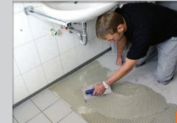
Auf dem Bodenausgleich Fliesen- oder Plattenbelag wie gewohnt verlegen und verfugen.
