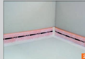
PCI Pecitape Silent rundum an allen aufgehenden Teilen 1 cm breit verlegen. Heizmattengitter auf dem Boden ausrollen.
